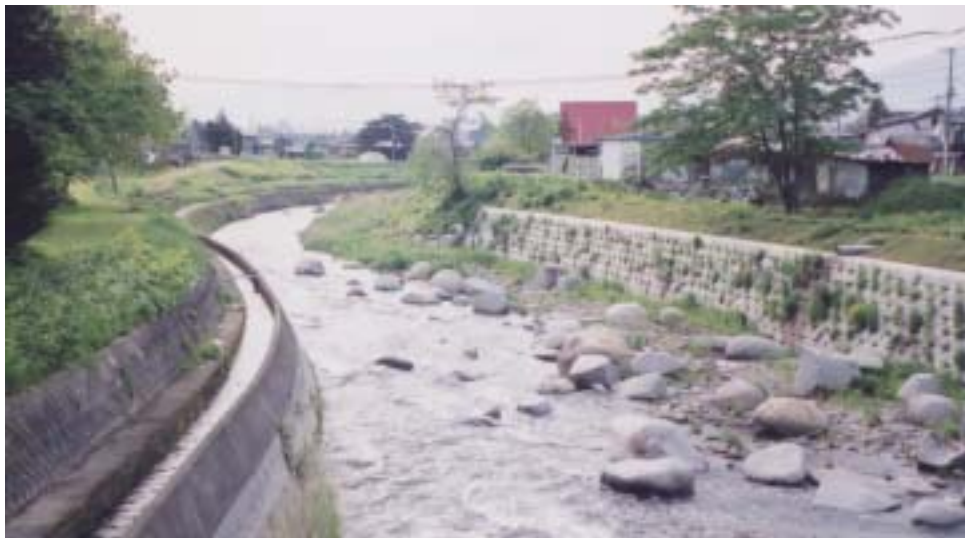
写真 - 4.2 付近の河道の状況と右岸側の住宅
