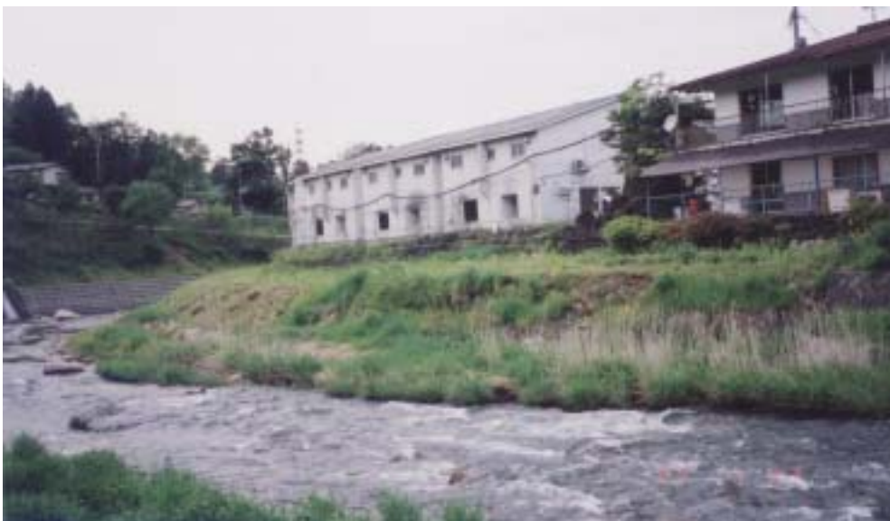
写真 - 4.3 付近の河道の状況と右岸側の住宅
