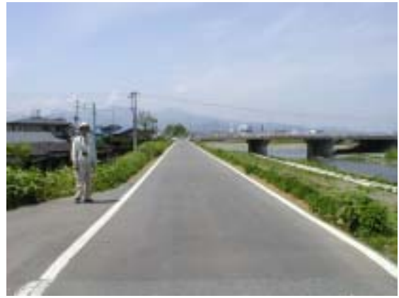
写真 - 4.1(b) 2004年5月23日の調査時の状況
