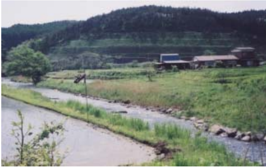
写真 - 4.4 付近の河道の状況と右岸側の住宅
