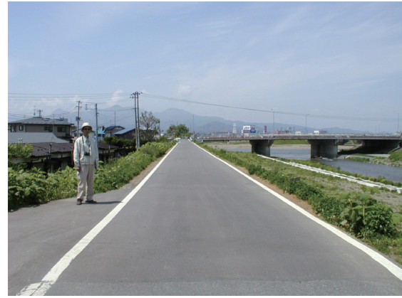
写真-4.1(b) 2004年5月23日の調査時の状況
