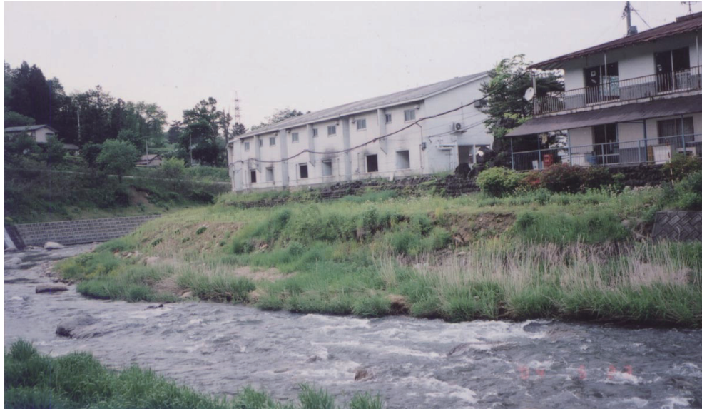
写真－4.3 ⑦付近の河道の状況と右岸側の住宅
