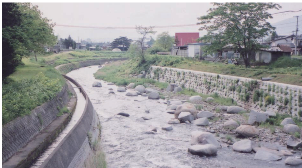
写真-4.2 ⑤付近の河道の状況と右岸側の住宅
